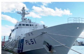
巡視船通信機器設備
